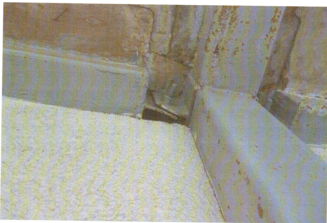
ФОТО №6. Отклонения линии стоек от вертикали
